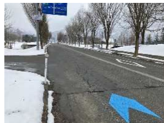
消雪パイプ設置路線
