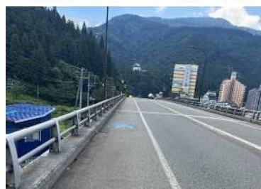
矢羽根型路面表示の設置
